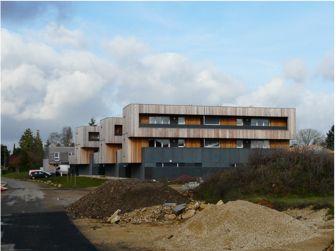
Mérigotte - Construction logements
