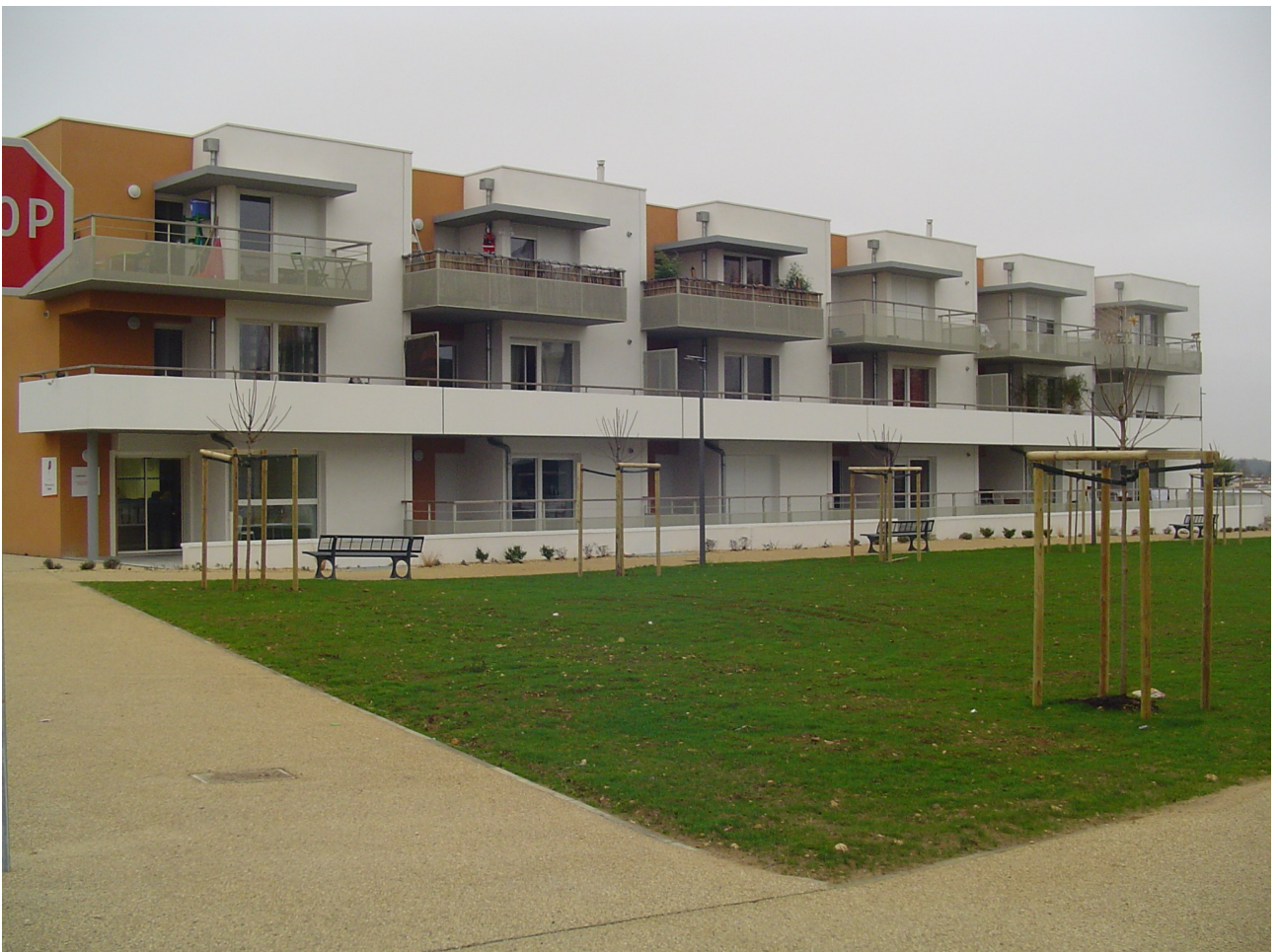
Bel Air - Création de logements
