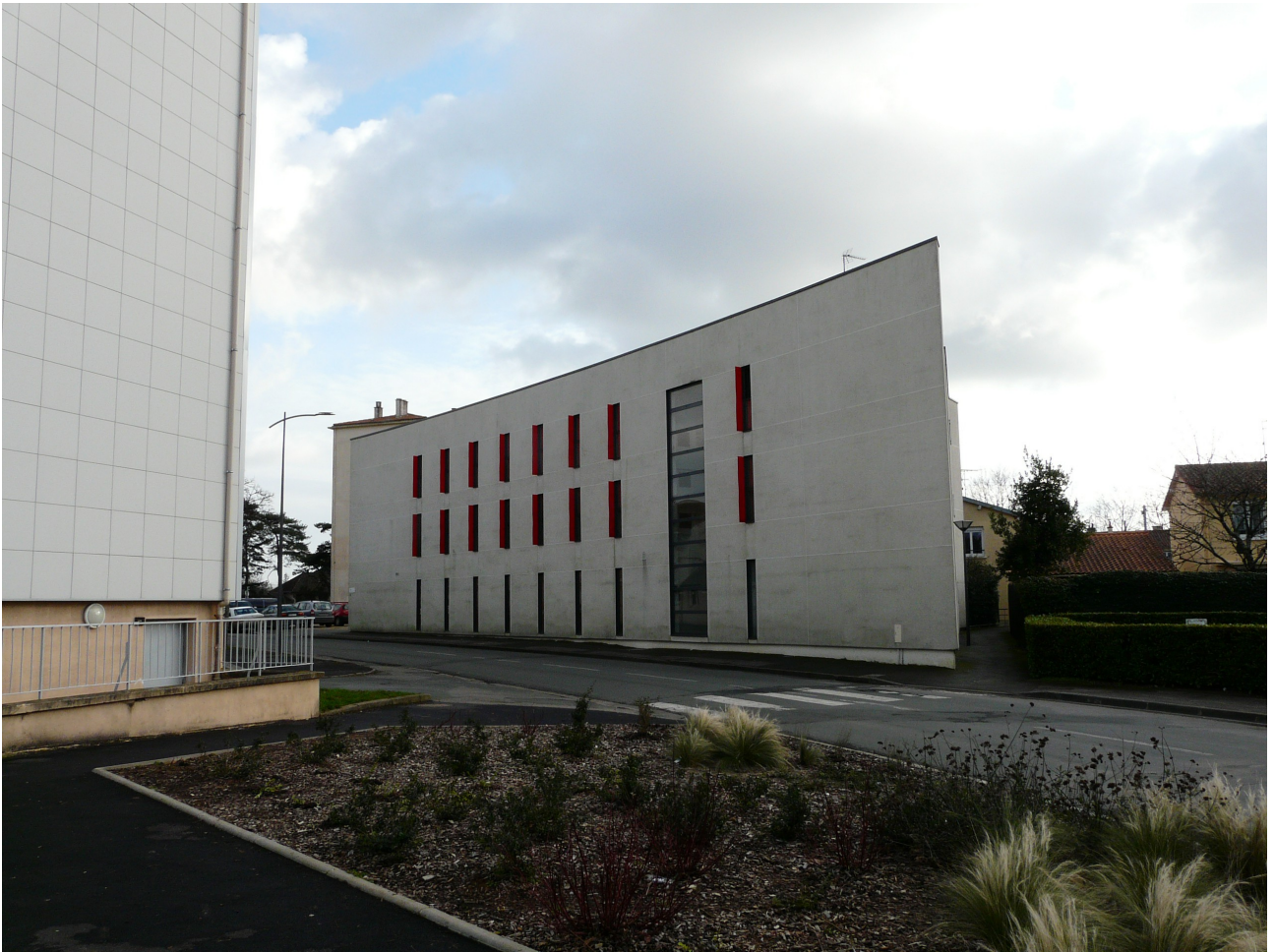
Piquetterie - Foyer logement
